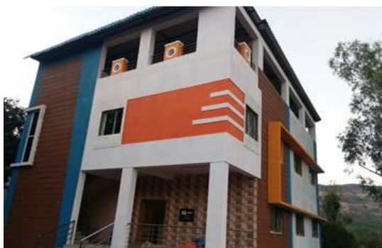
完成したセンター建物
